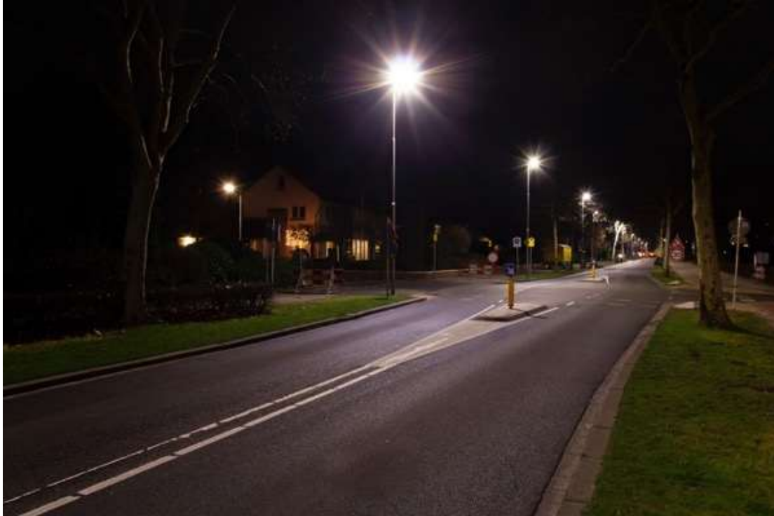
Foto: Thorbeckelaan in Barneveld voorzien van ledverlichting
